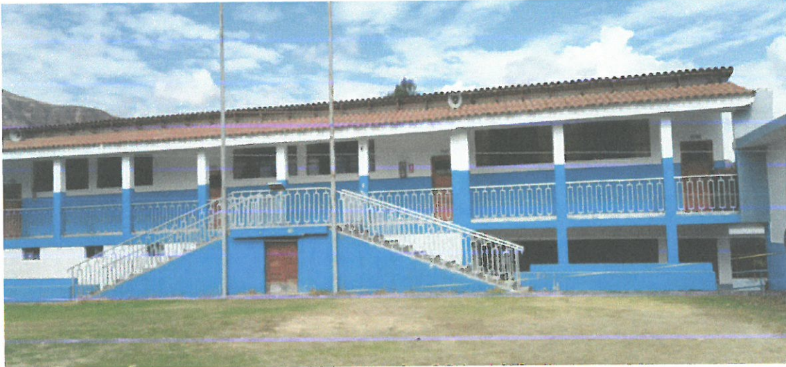
PABELLON "I" VISTA LATERAL PRIMER PISO
