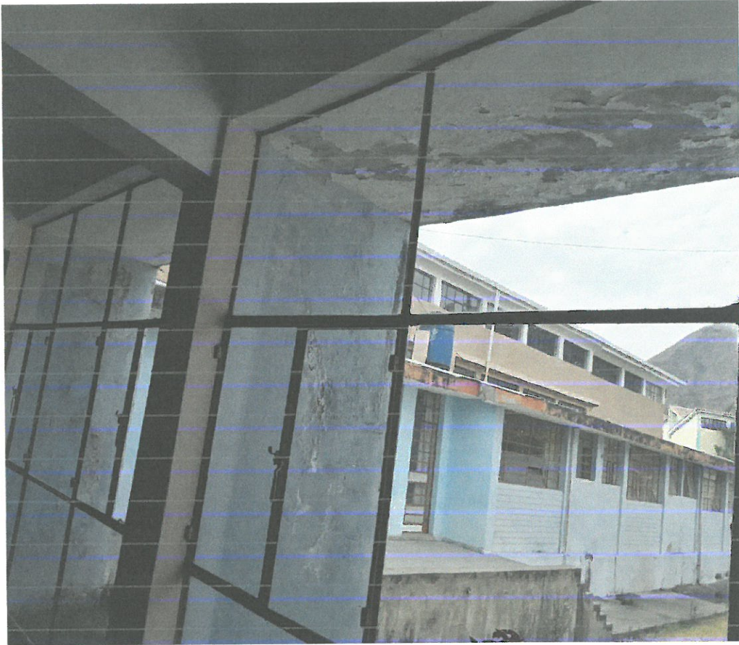
PABELLON "1" FOTO PASADISO INTERIOR
