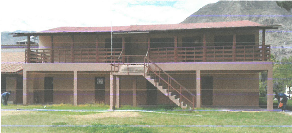
PABELLON "F" VISTA FRONTAL SEGUNDO PISO
